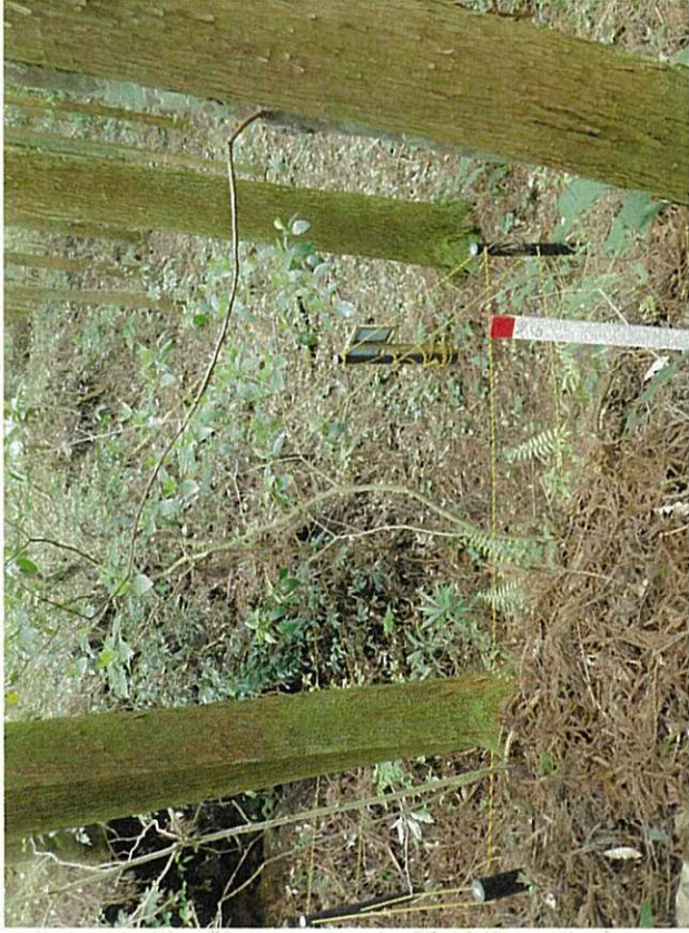
令和2年4月15日撮影(定期点検)
